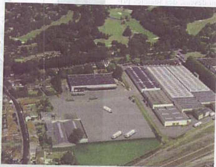
Le site de Villeneuve-d'Ascq.
